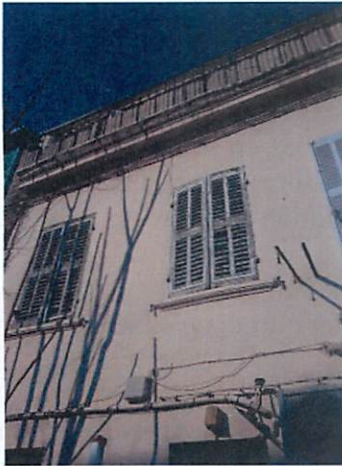
Volets en bois en façade.
